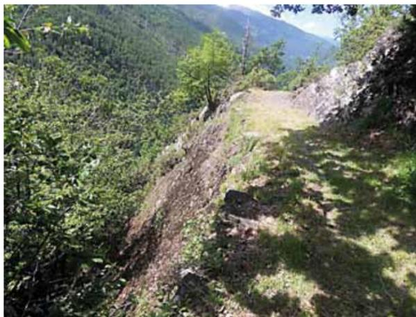
A valle della strada: ruderi di una baita sicuramente non anteriore all'800. In questa zona i muri di sostegno raggiungono m 3 di altezza e sono parzialmente crollati per brevi tratti. Questi crolli e quelli successivi a qualche centinaio di metri a monte, hanno messo in evidenza un tratto di muro seicentesco ed uno stra-
